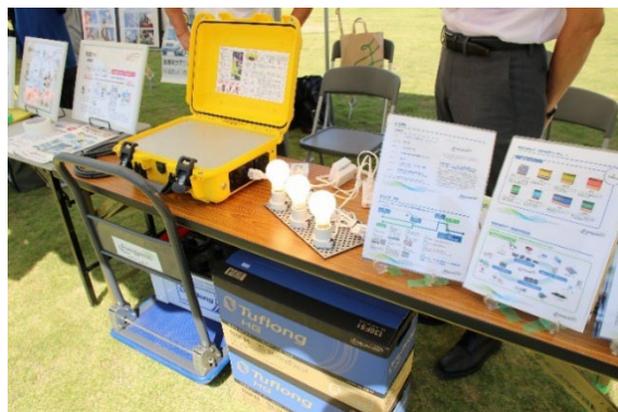
写真下部・自動車バッテリーを 左側・インバータ(黄色)に接続し、コンセント給電
