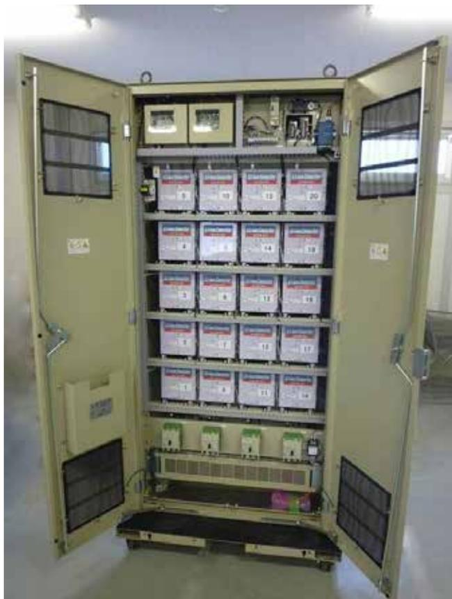
図 13 32 セルモジュールを組み込んだキュービクル
